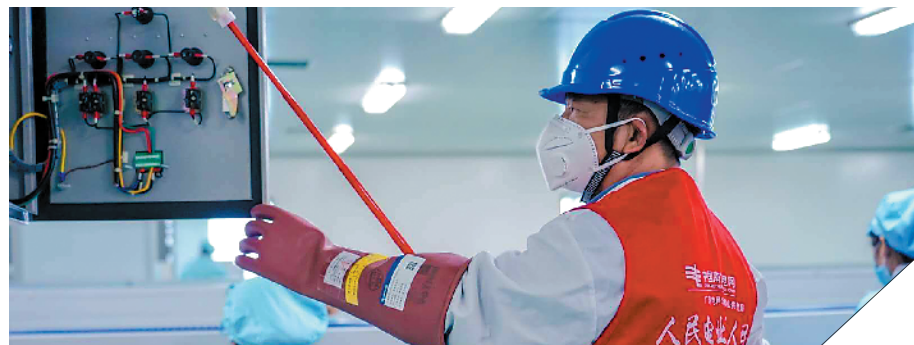
佛山南海供电局里水供电所共产党员服务队到广东一方制药有限公司上门服务 李权权 摄
