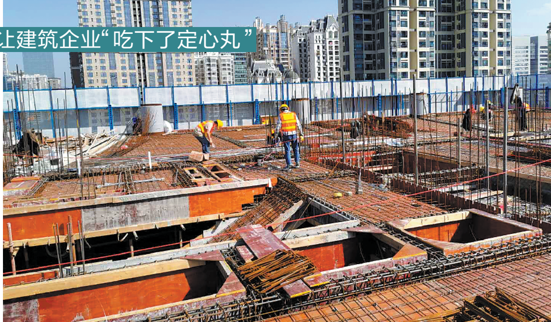
南塔工地复工复产现场
