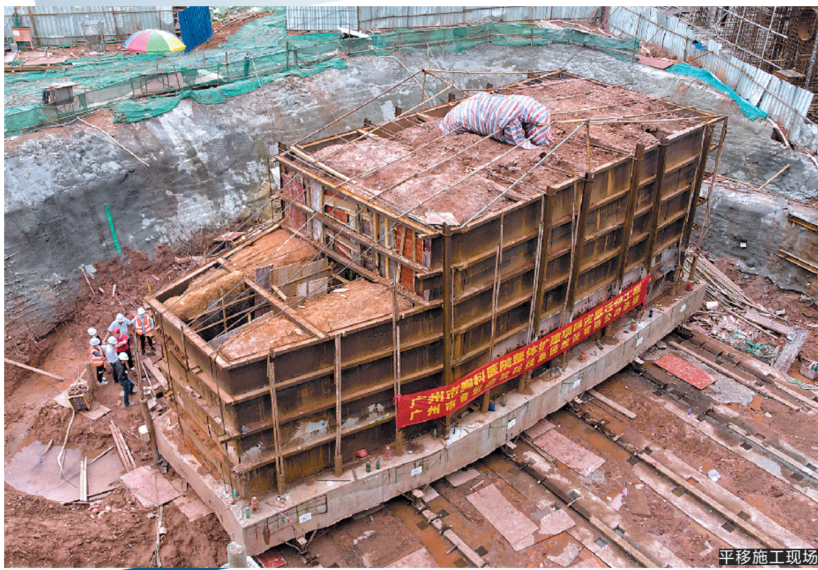
平移施工现场
