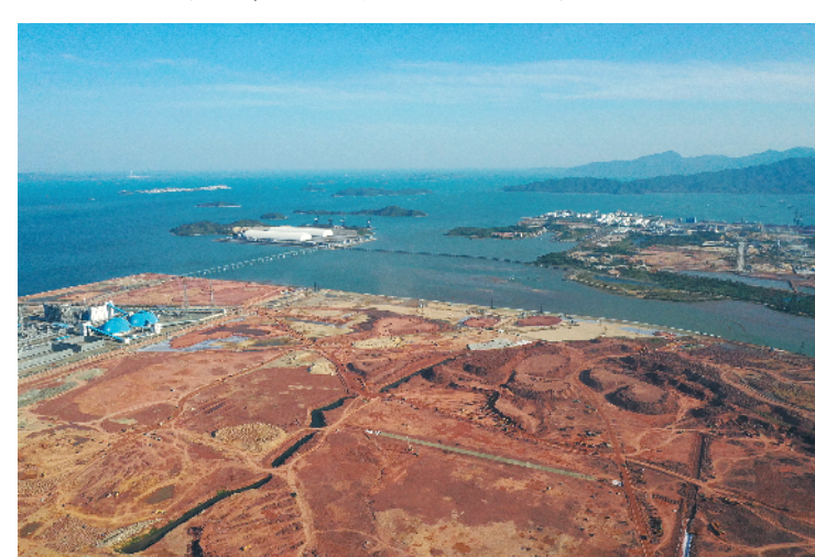
项目开工现场 王建桥 摄
