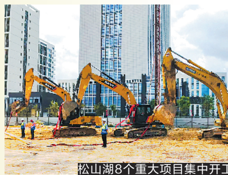
松山湖8个重大项目集中开工
