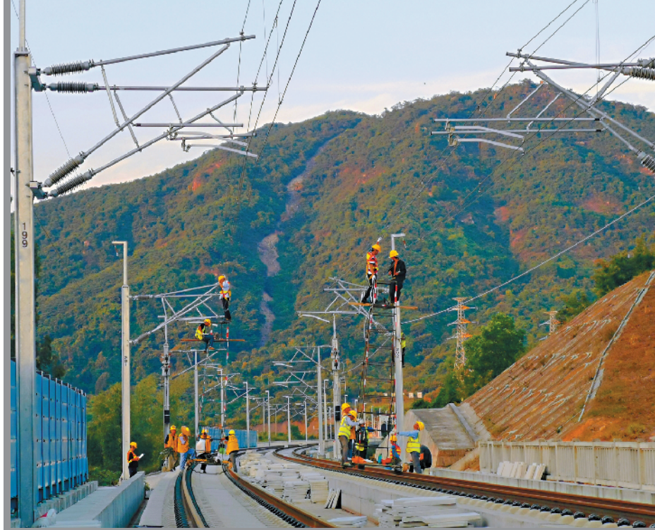
9日，随着广州北站最后一个锚段接触网悬挂调整完成，连接广州市与清远市的广清城际铁路接触网工程实现全线贯通。
