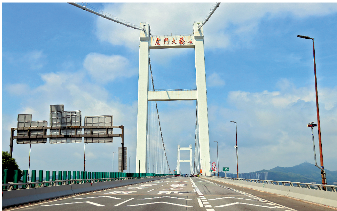
安全评估表明：虎门大桥悬索桥结构技术状况和承载性能保持稳定 羊城晚报记者 王丹阳 摄
