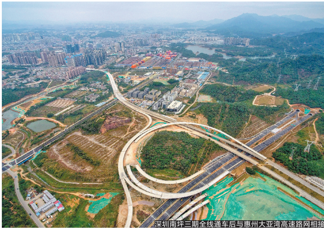
深圳南坪三期全线通车后与惠州大亚湾高速路网相接
