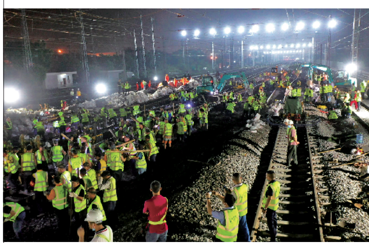
拨接施工现场
