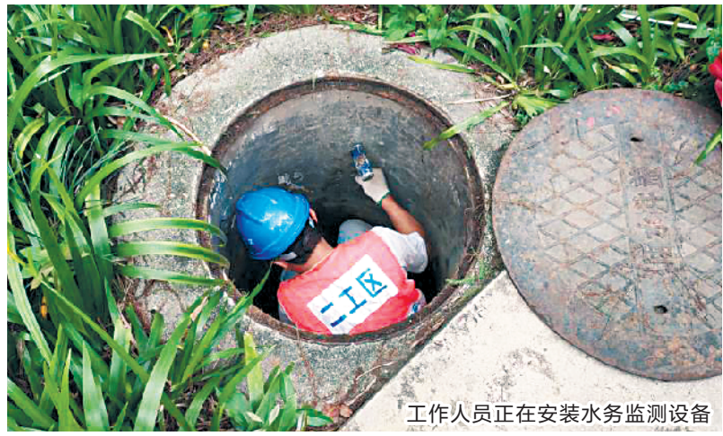
工作人员正在安装水务监测设备
