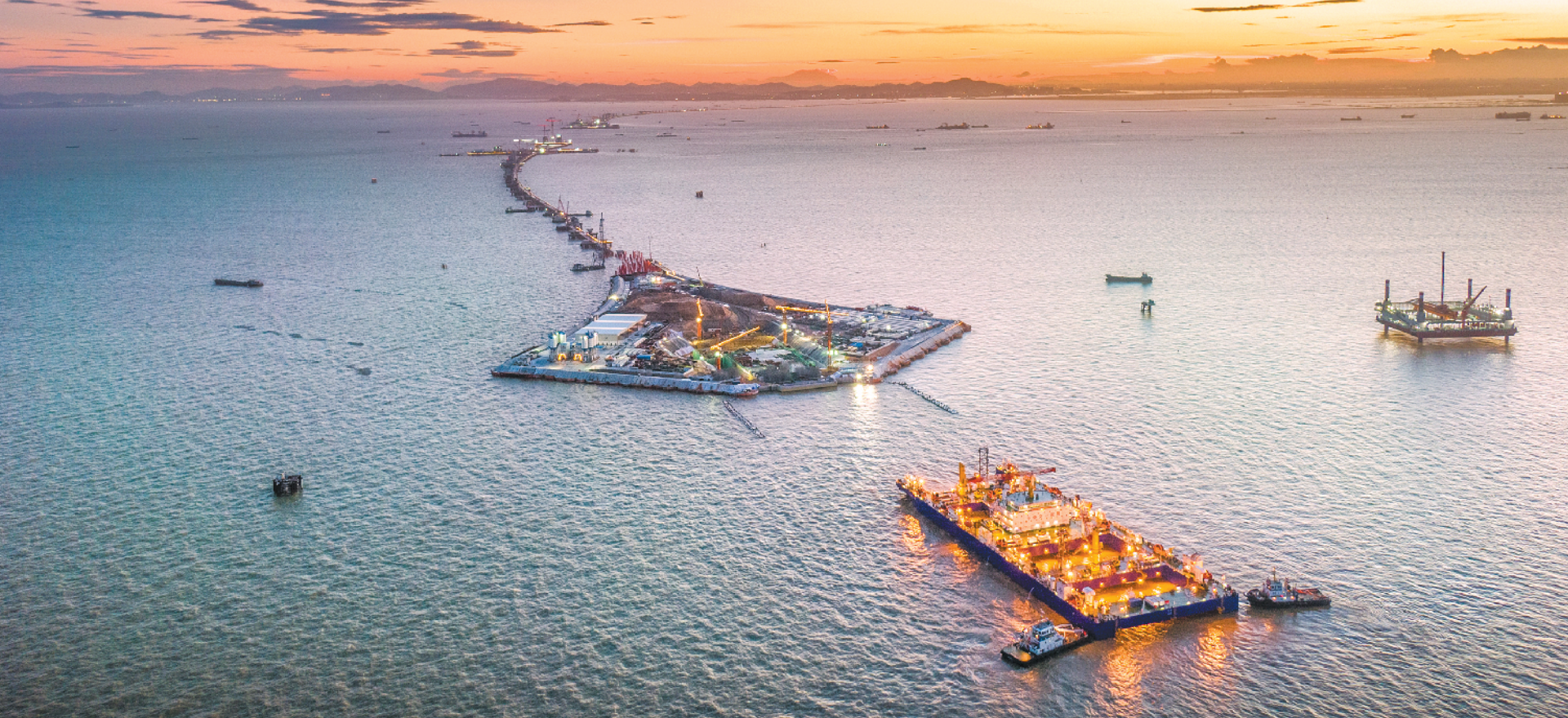
16日傍晚，深中通道首节沉管浮运编队顺利到达系泊区域，开始沉管系泊作业，为正式沉放对接做准备 羊城晚报记者 王磊 摄
