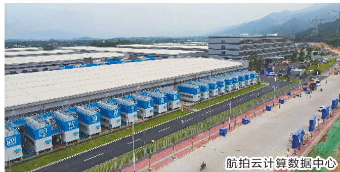
航拍云计算数据中心
