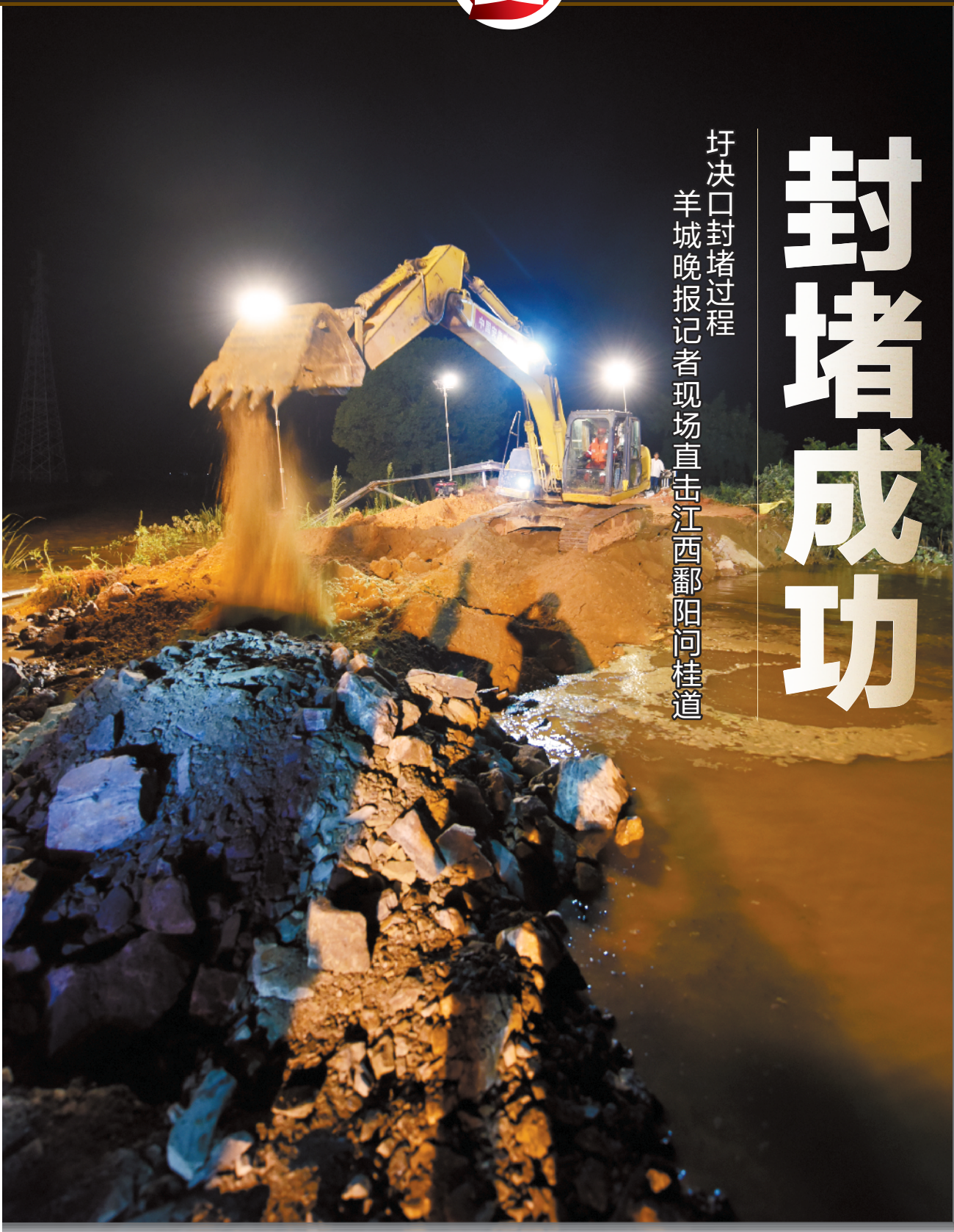
13日晚,江西上饶鄱阳县鄱阳镇的问桂道圩堤漫堤决口成功合龙
