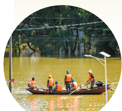
电力工作人员乘坐小船为村里的高压电线杆添加警示标志 宋金峪 摄
