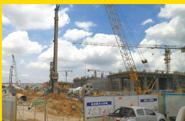
正在建设中的与龙穴岛联系的桥梁
