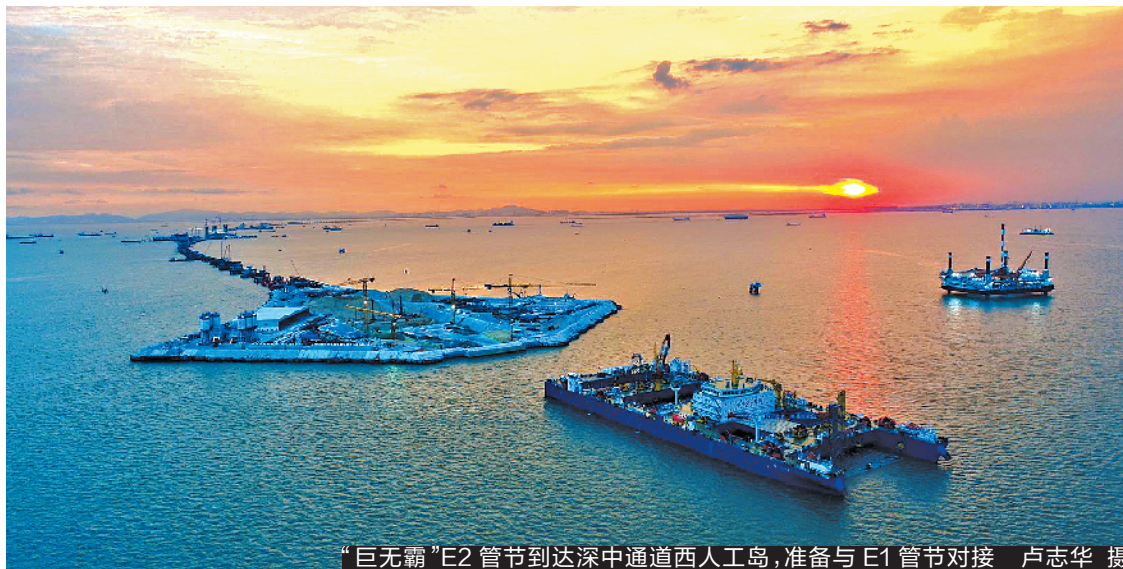
“巨无霸”E2管节到达深中通道西人工岛，准备与E1管节对接 卢志华 摄
