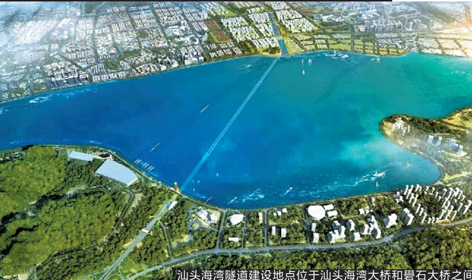
汕头海湾隧道建设地点位于汕头海湾大桥和礮石大桥之间
