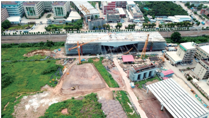
深圳外环高速公路东莞段跨广深铁路桥转体桥转体重量在全国已建转体桥梁中排名第四
