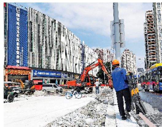
华林寺站用金属护栏取代临街的围蔽工程墙
