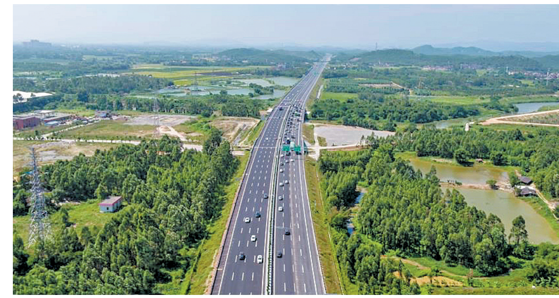
22日,开阳高速凤山互通到北惯互通路段62公里双向八车道开放通行
