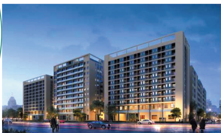
茶山镇必拓智慧光电产业中心项目
