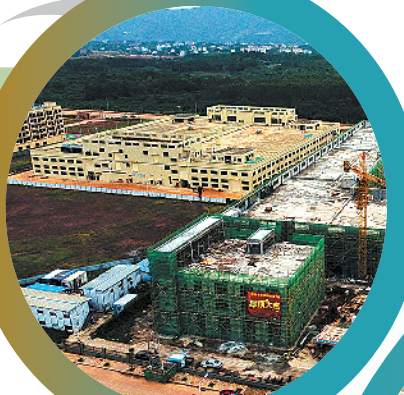
河源高新区东方硅源科技项目主体建筑已封顶 刘海有摄
