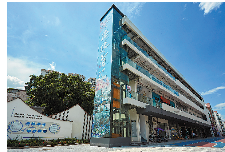
海珠智汇科技园
