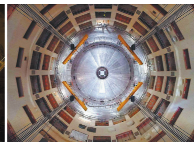
低温恒温器的基座 图片来源:ITER
