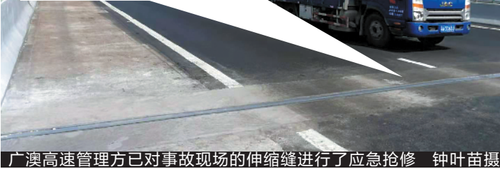
广澳高速管理方已对事故现场的伸缩缝进行了应急抢修 钟叶苗摄
