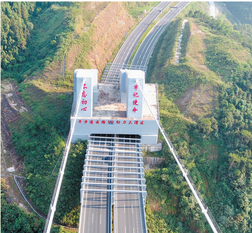
肇云大桥在桥上搭“隧道”,解决塔锚“牵手”难题
