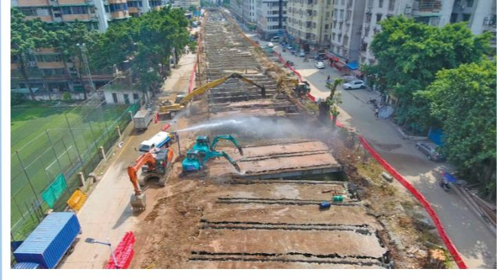
白云区棠景沙涌合流渠箱，采取“揭盖复涌”方式完成雨污分流改造
