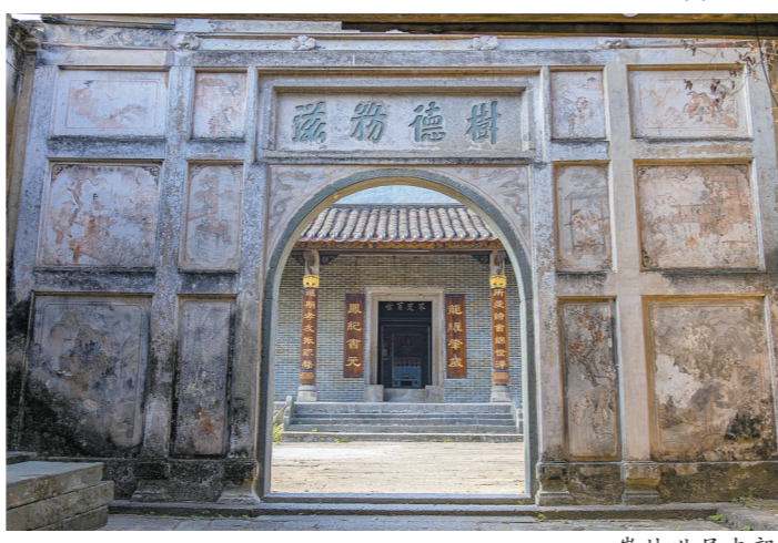
崇林世居内部
