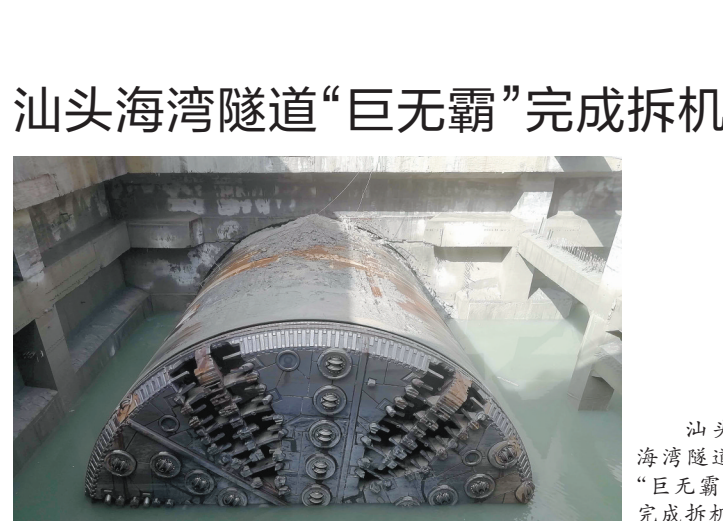
汕头海湾隧道“巨无霸”完成拆机
