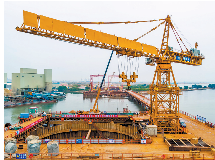
目前亚洲最大吨位的塔吊D5200-240正在紧张作业
