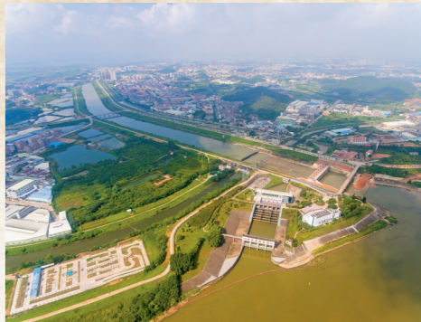
东深供水东莞桥头段 羊城晚报记者 王俊伟 摄
