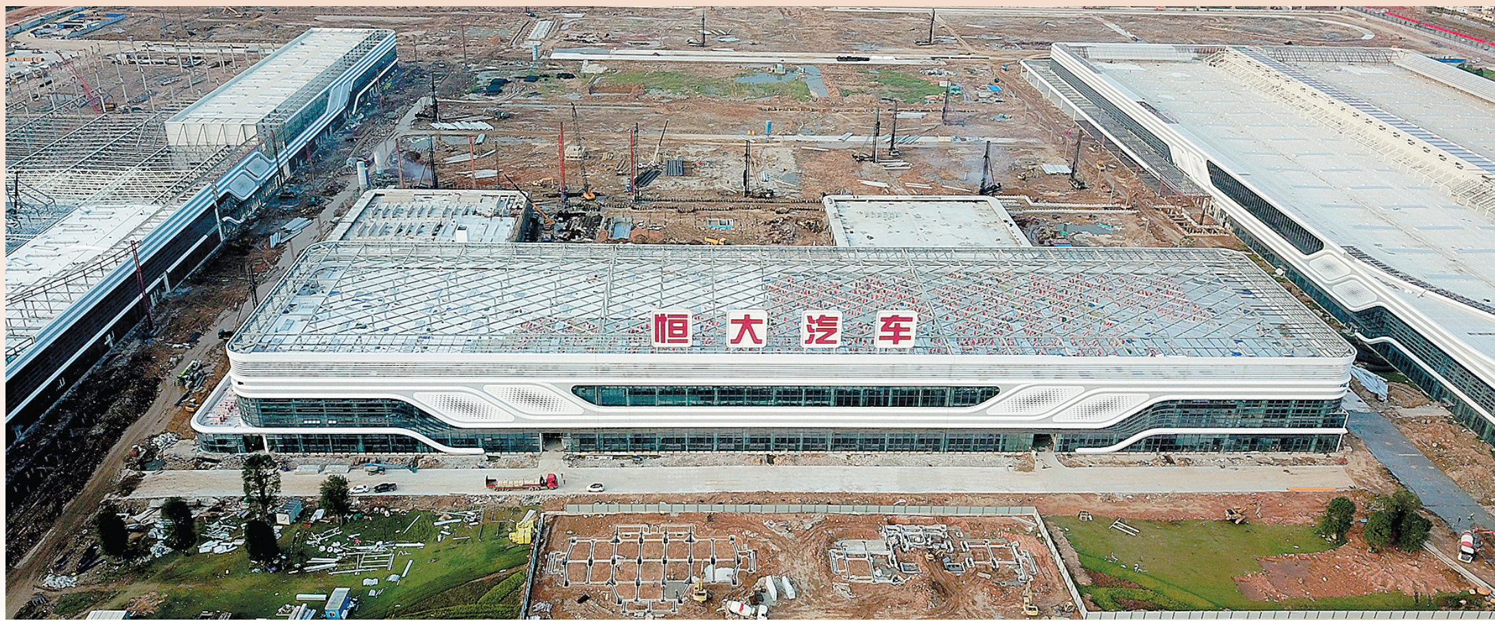
广州新能源汽车项目建设现场
