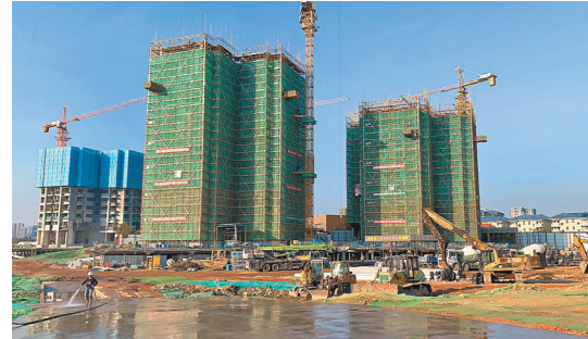
案例3 江门保利江湾大都汇项目从拿地到办理施工许可仅用了76个自然日
