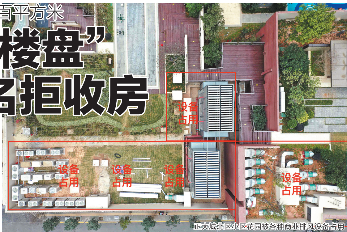
正大城北区小区花园被各种商业排风设备占用
