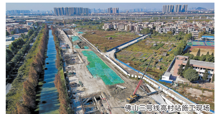
佛山三号线高村站施工现场
