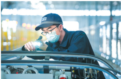
检修空调通风设备
