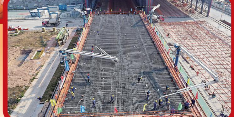
2月2日下午,历时12小时,深中通道项目首幅60米混凝土箱梁在中铁大桥局深中通道项目S07合同段智慧梁场浇筑成功。这标志着深中通道项目60米混凝土箱梁施工拉开序幕,智慧梁场迈入规模化智能制造施工的新阶段。据了解,这片箱梁浇筑完成后重达2752吨,梁体顶部面积1200平方米。
