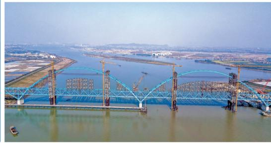
**羊城晚报讯** 记者李志文、张豪,通讯员范彩燕、杨胜、王立冬摄影报道:2月3日,粤港澳大湾区重点项目南沙港铁路建设取得重要进展,洪奇沥水道特大桥主桥钢桁梁柔性拱顺利提升(见图),即将实现高空毫米级精确合龙,意味着这座有着“亚洲第一跨”美誉的特大柔性拱钢桁梁桥即将完成施工,为确保南沙港铁路年底具备开通条件奠定了坚实基础。
