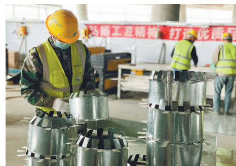
汕头亚青会场馆建设现场
