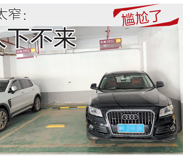
涉事车位所停车辆左侧车门无法正常打开
