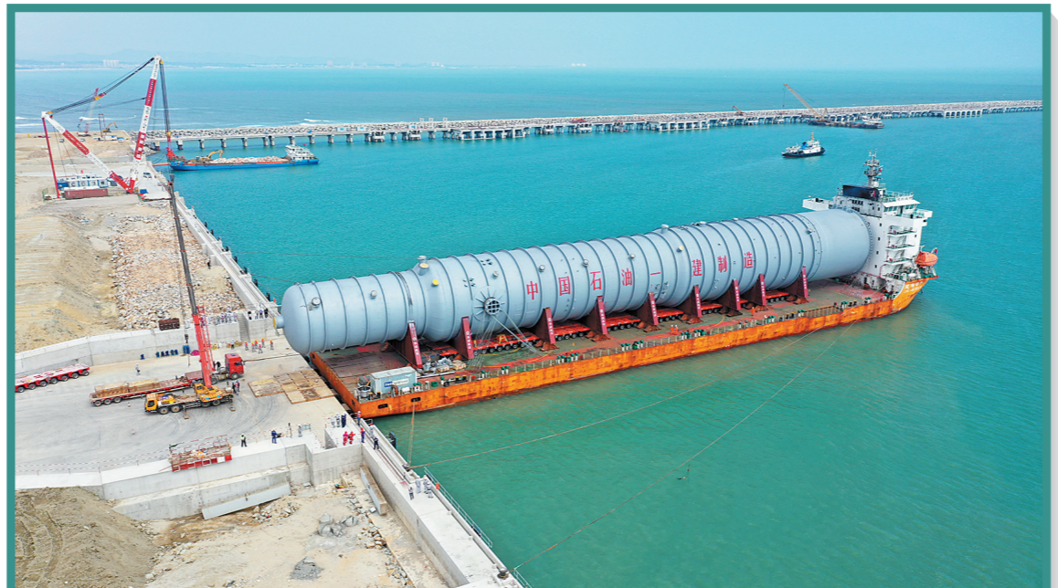
亚洲最大单体石化塔器运抵揭阳项目建设现场 贝宇旭 摄
