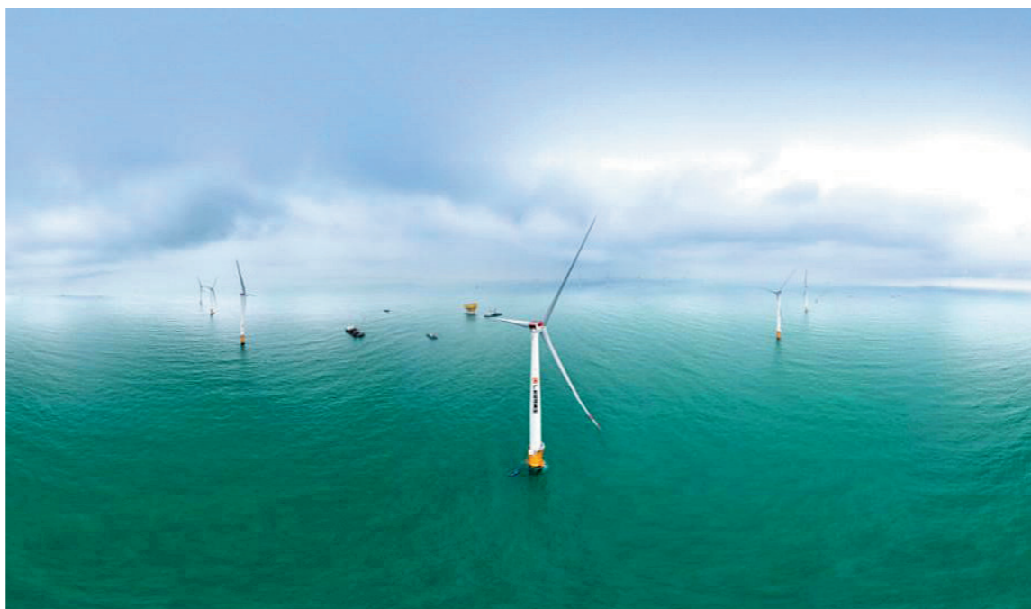
截至去年年底，广东海上风电并网总容量突破100万千瓦，图为航拍的珠海金湾海上风电场
