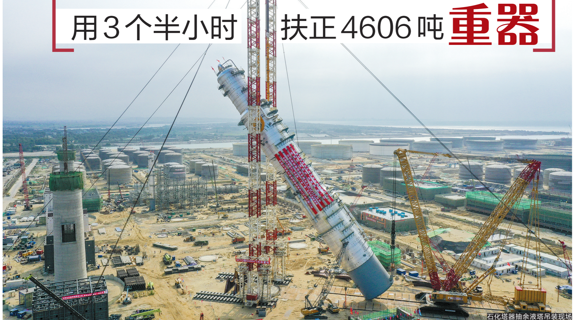
石化塔器抽余液塔吊装现场
