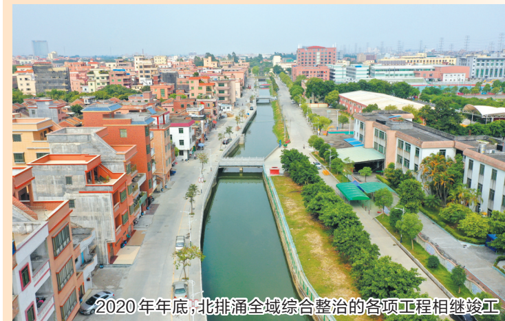
2020年年底，北排涌全域综合整治的各项工程相继竣工
