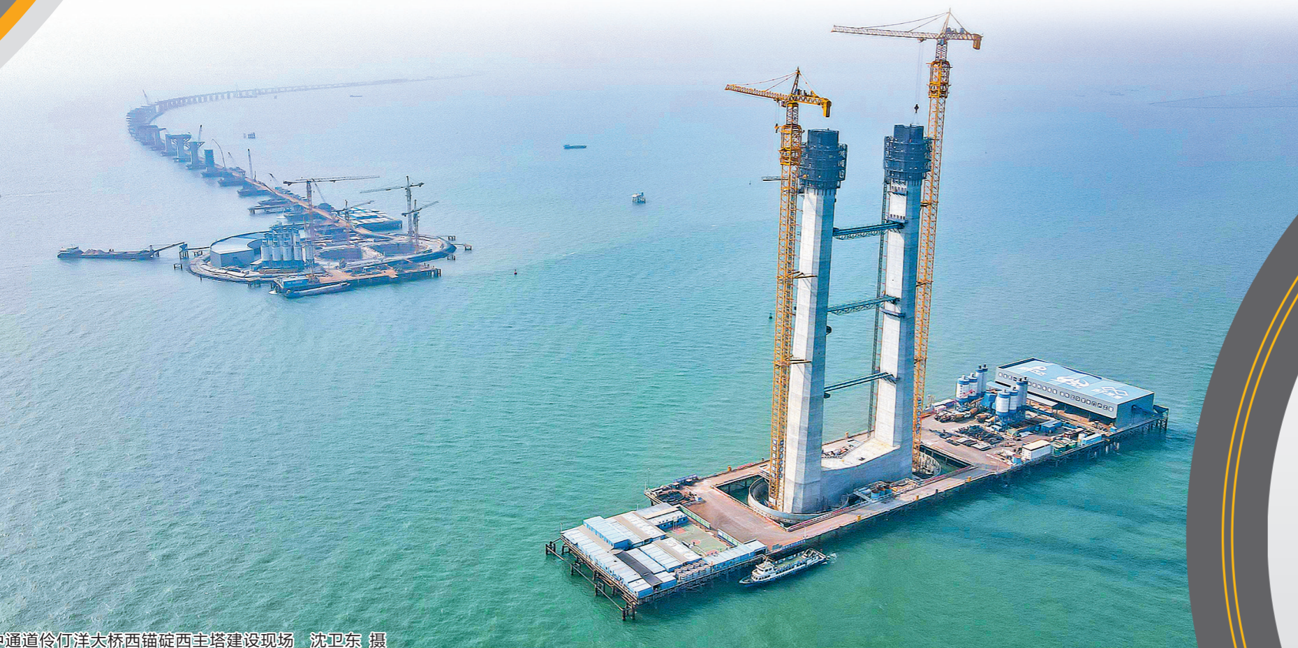
深中通道伶仃洋大桥西锚碇西主塔建设现场 沈卫东 摄
