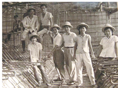
广工学子在东深工程施工现场学校供图
