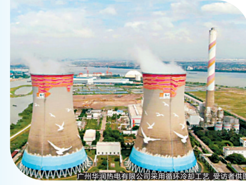
A 严格全程用水管控 多项供水设施改造
