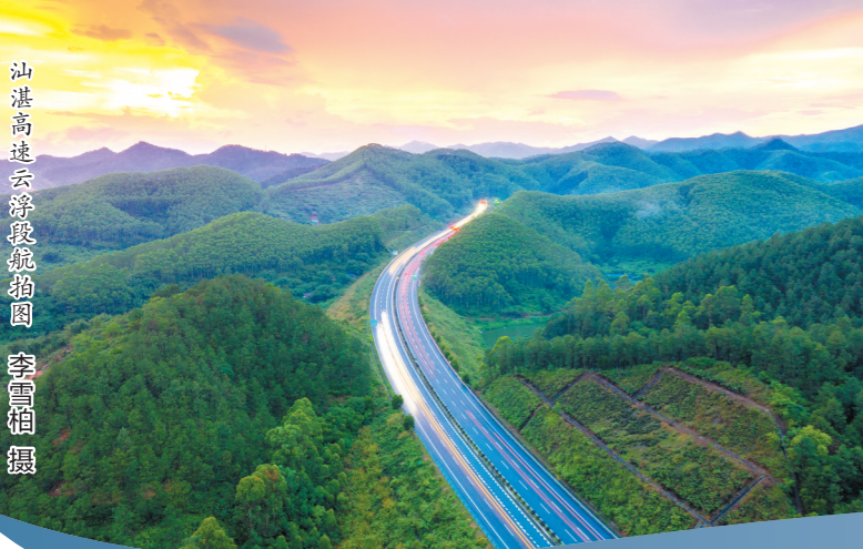
汕湛高速云浮段航拍图 李雪梅摄
