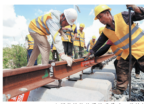
工人调整铁轨位置接通最后一段铁轨
