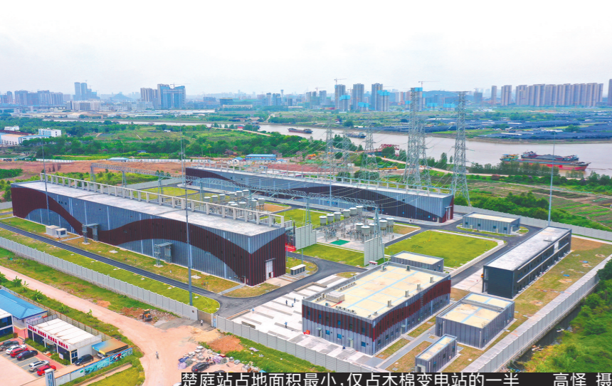
楚庭站占地面积最小,仅占木棉变电站的一半 高辉 摄
