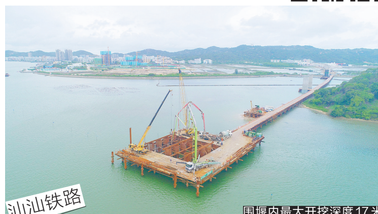
围堰内最大开挖深度17米
