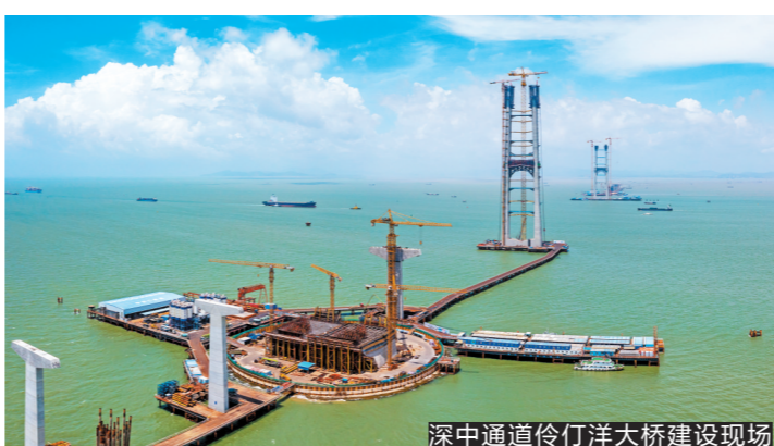
深中通道伶仃洋大桥建设现场
